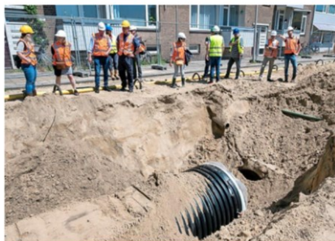
De eerste stukken buis liggen al in de grond.
