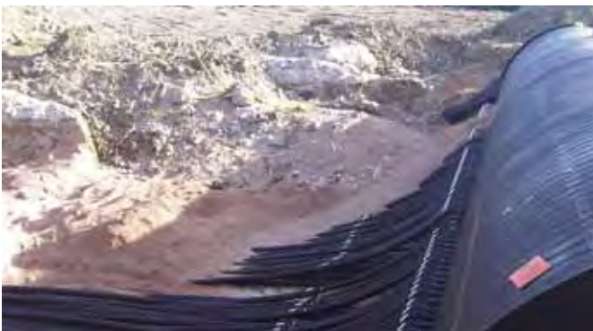
Verbindingsleiding aan de verdelerput in horizontale bouwrichting
