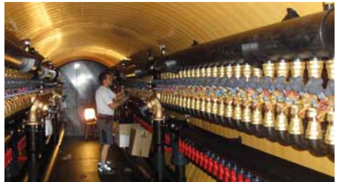
Verdelercomponenten in de verdelerput
